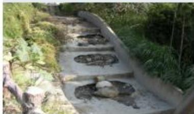
堤防、固床工等混凝土結構物受土石流磨損。
