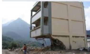
土石流流動時撞擊力極強，易將構造物撞毀穿透。
